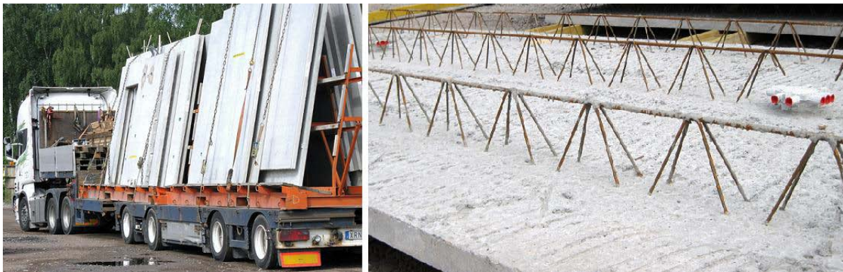
Figur 4. Till vänster: Transport med skalväggar. Till höger: Plattbärlag. Lägga märke till att betongelementet är delvis färdigarmerat samt att eldragning för exempelvis taklampor redan är förberedd.
