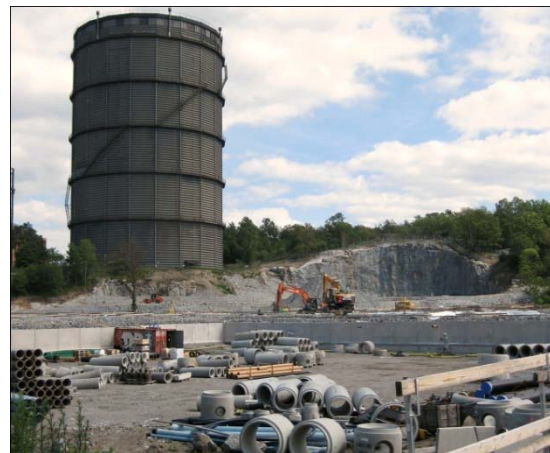
Figur 3. Pågående markarbeten i etapp Västra. Ytan för kommande husbyggnation utgör goda lagringsmöjligheter för bland annat rördelar.
