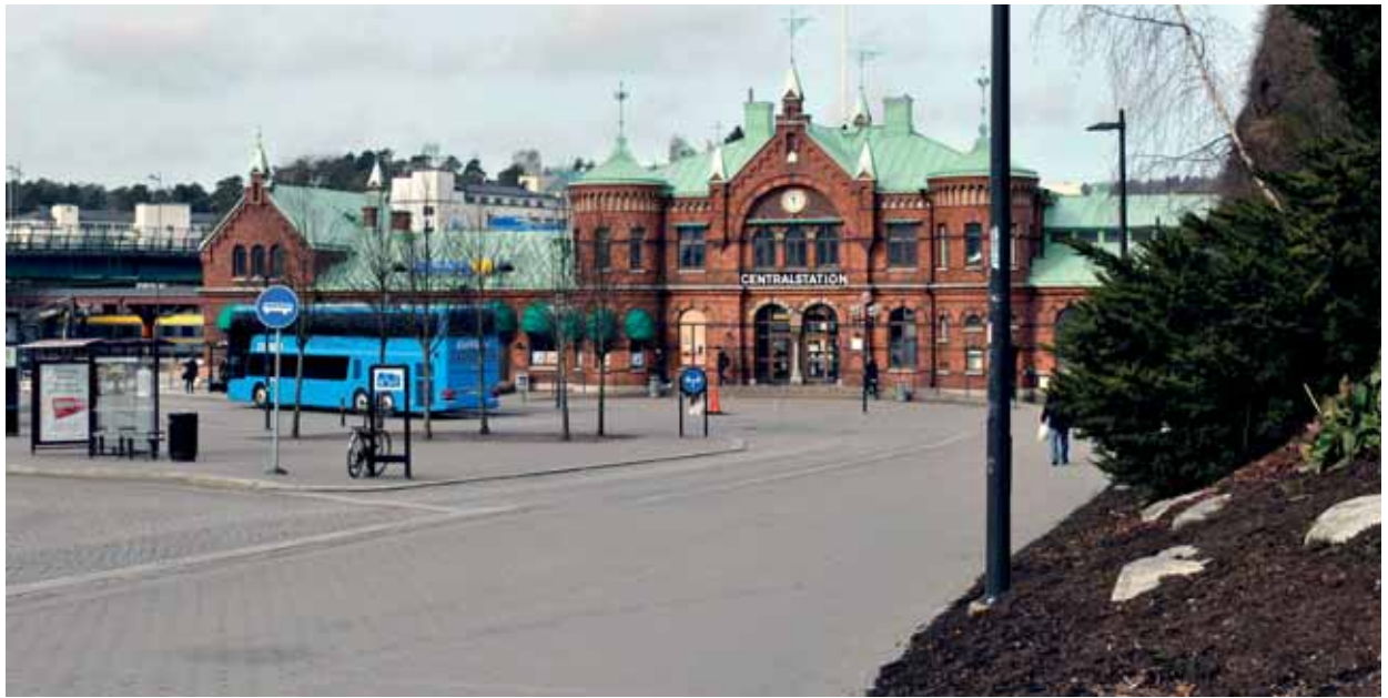
Figur 6.1. Järnvägs- och busstation i Borås.
