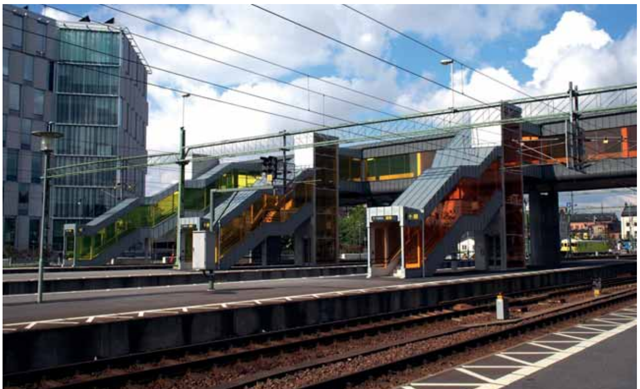
Figur 6.3. Nybyggnation och övergång vid stationen i Lund.
