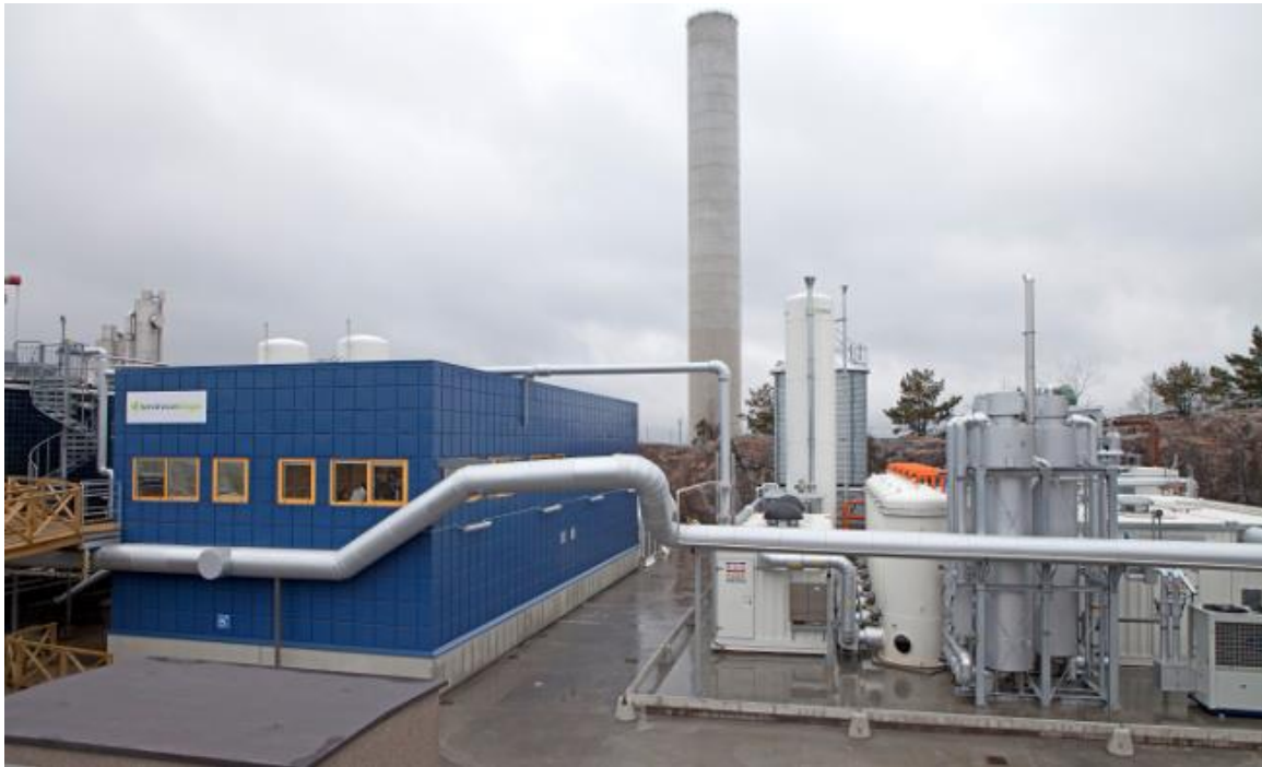
Produktionsanläggning för biogas i Henriksdal
